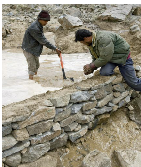
Construction d'un barrage pour stocker la glace
