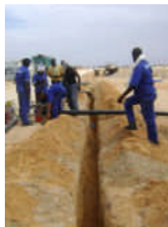
Pose de conduite à Riyad, l'un des quartiers de Nouakchott
