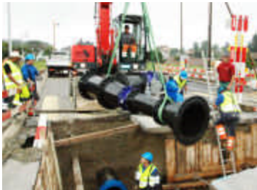
Nouveau défi lausannois : conjuguer réseaux d'eau et réseaux de transports
