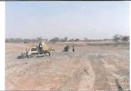
Inizio degli scavi a Zoungwaye
