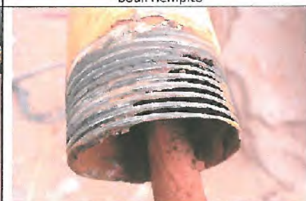
Sostituzione delle parti usurate
