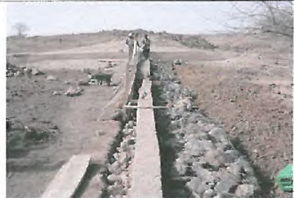
Riparazione muri di protezione
