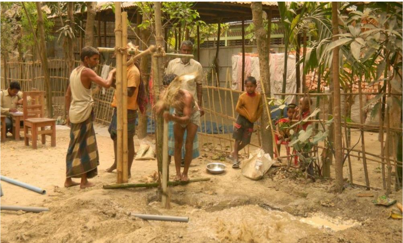
Installierung einer Handpumpe in einem Rohrbrunnen durch die Bewohner (Nutzniesser). | © Tdh
