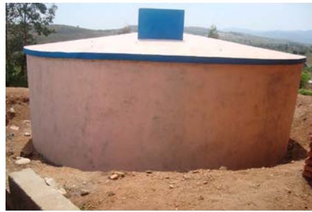
◀ Figure 4 Réservoir de 40 m 3 en construction
