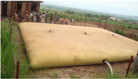
◀ Figure 5 Réservoir flexible de 100 m 3 à Muyange
