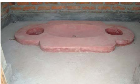
◀ Figure 10 Intérieur d'une toilette de type UDDT
