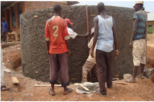
◀ Figure 4 Réservoir de 40 m 3 en construction
