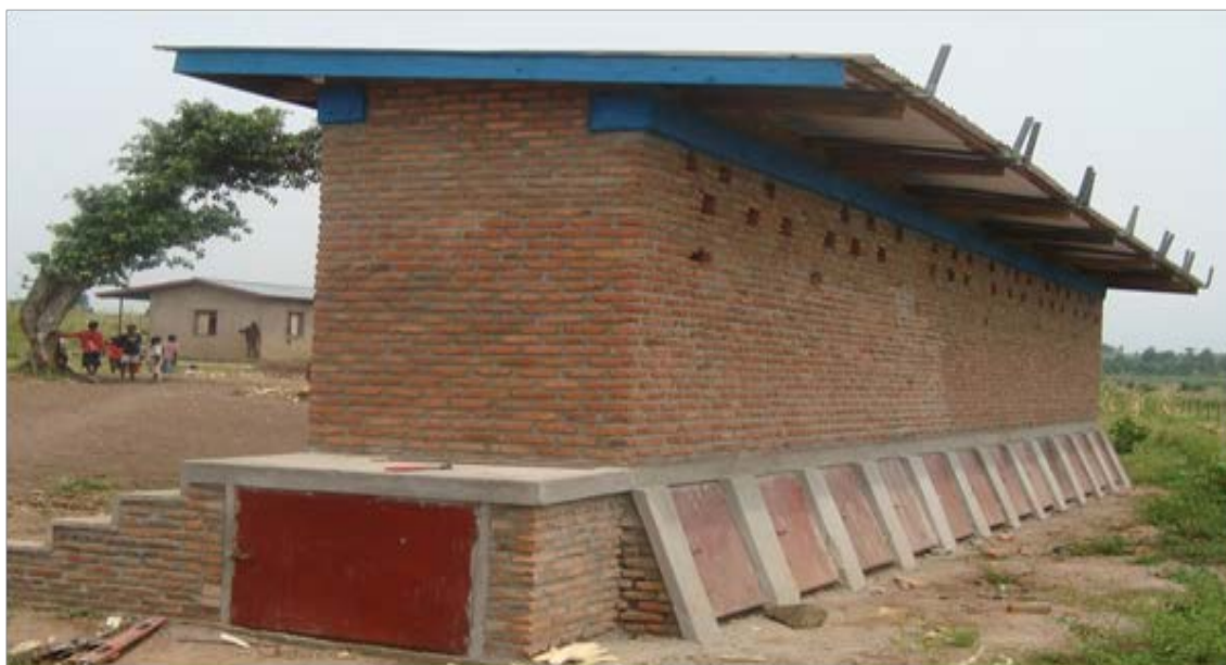
◀ Figure 12 Vue arrière des toilettes avec portes arrière pour vidanges des latrines
