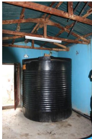
Réservoir en place et toit remonté
