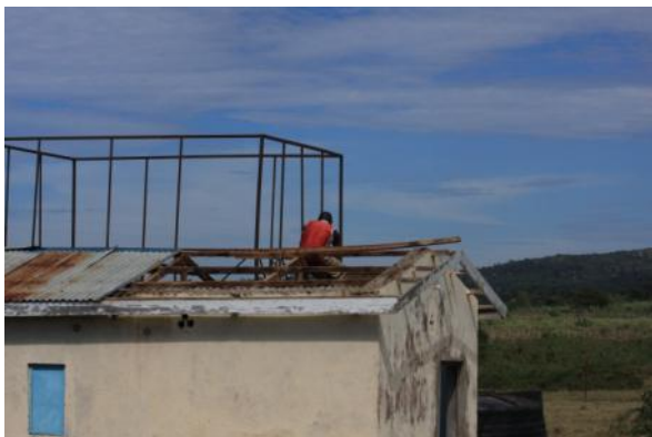
Démontage du toit
