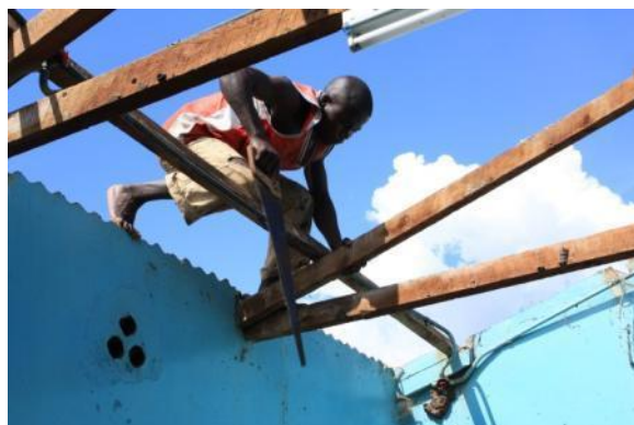
Sciage des poutres du toit
